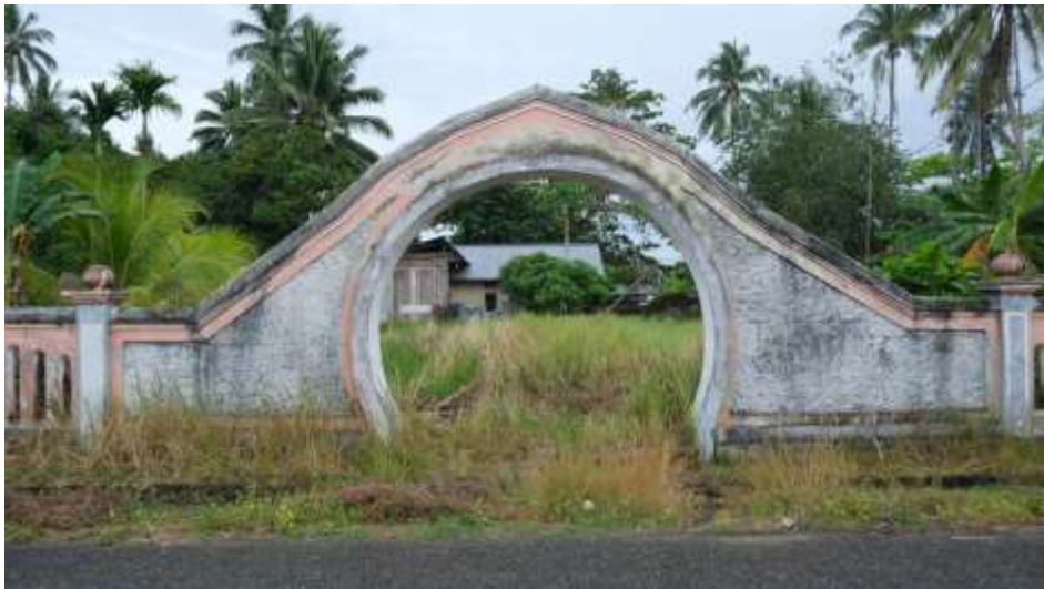
Pintu masuk baru di tepi jalan raya sebelum mencapai struktur.
